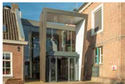
Adres: Marktplaats in Lith Bevestiging: cassette en verlijmd Realisatie: 2019
